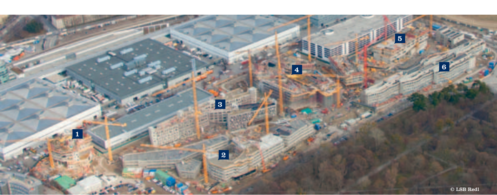
Baustelle fotografiert im Winter 2011/12
